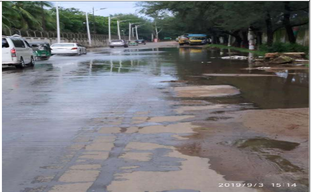
বিমানবন্দর সড়কের উন্নয়ন
