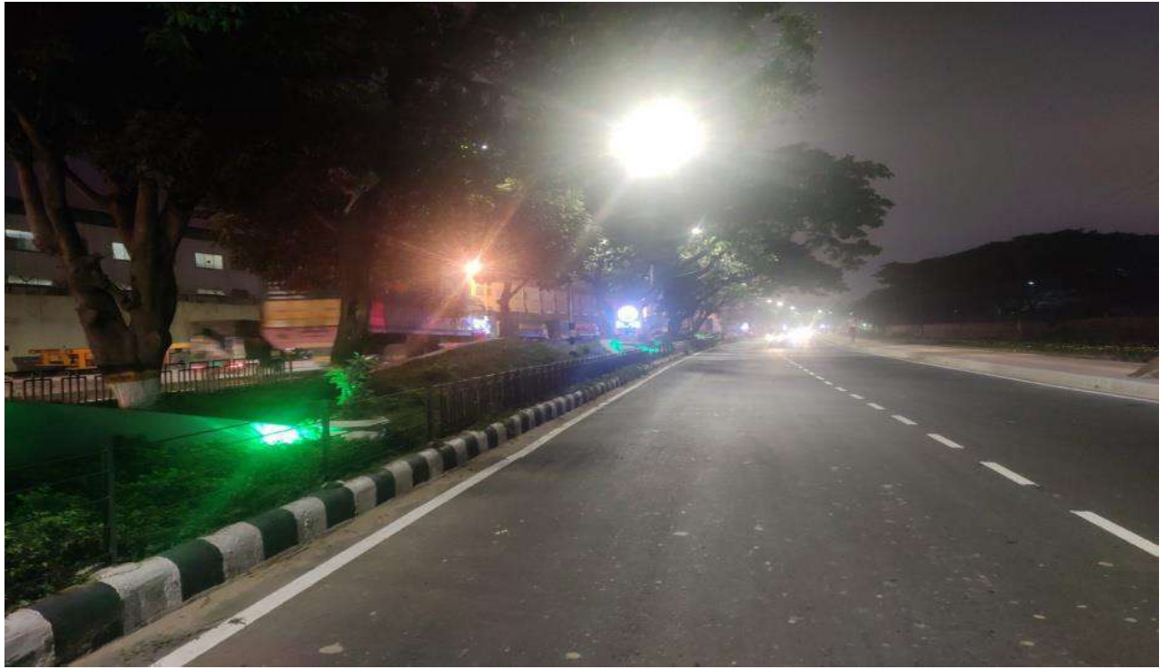
বিমানবন্দর সড়কের উন্নয়ন
